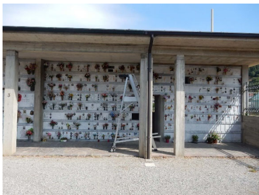
ossari di nuova costruzione
