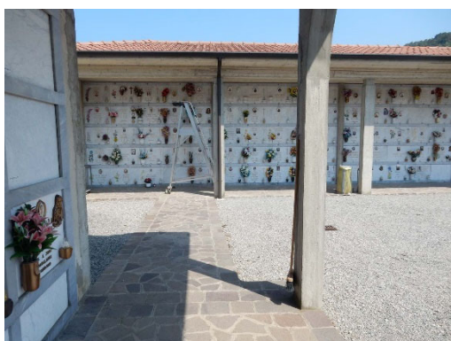
percorsi pedonali pavimentati
